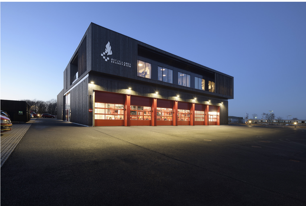
Ny brandstation i Højbjerg – Station Aarhus Syd
