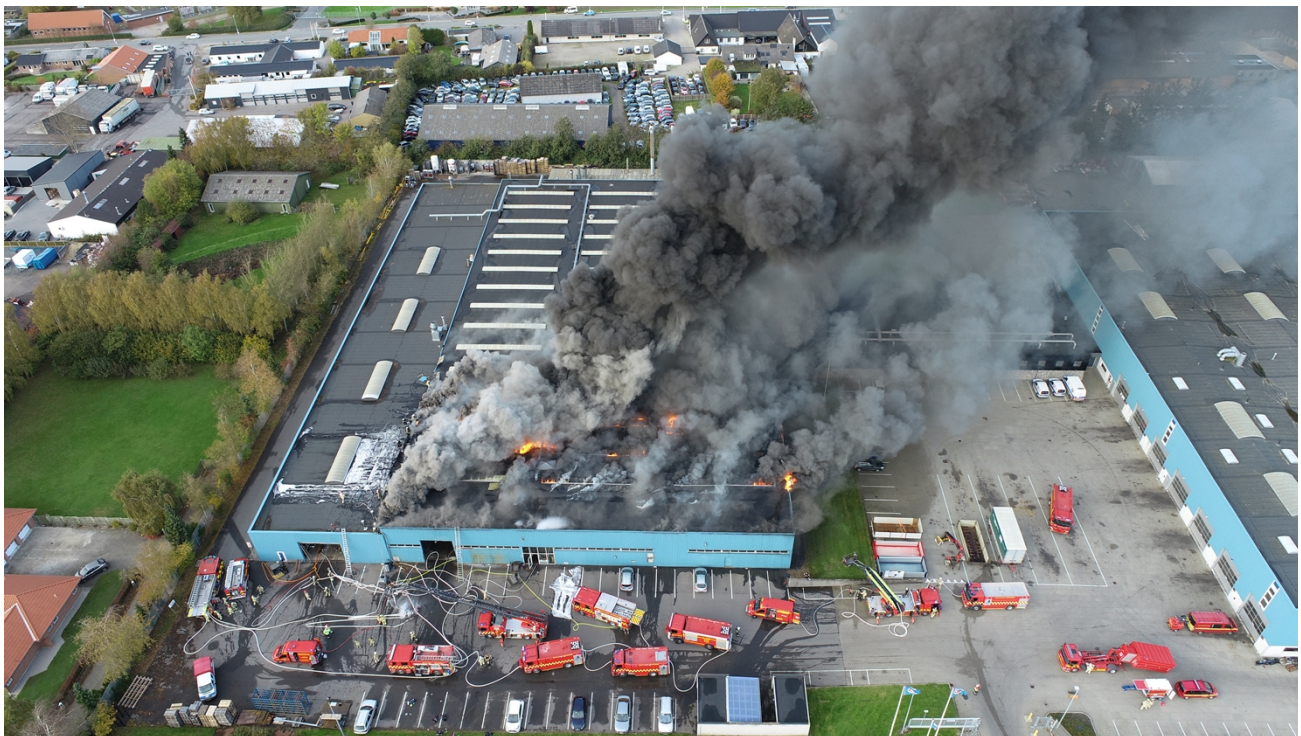
Fig. 1 Brand hos Højbjerg Maskinfabrik i Galten, 2021
