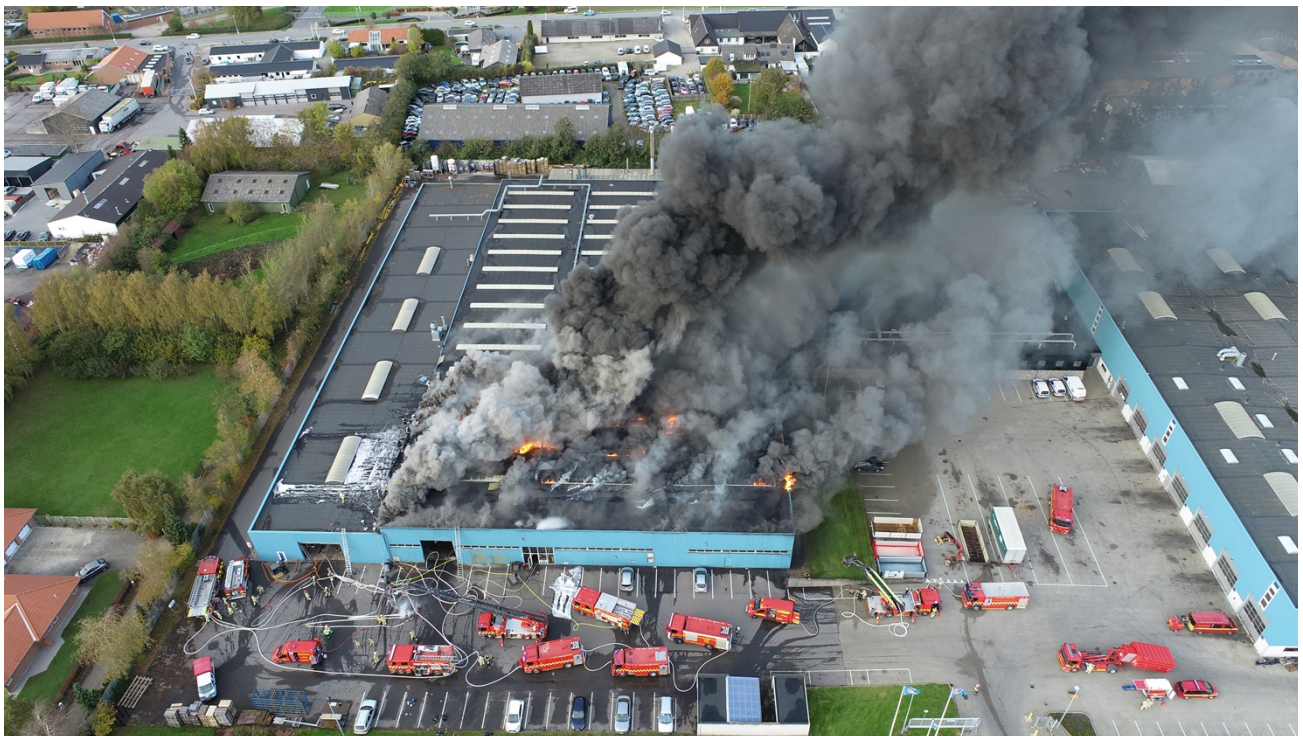
Fig. 1 Brand hos Højbjerg Maskinfabrik i Galten, 2021
