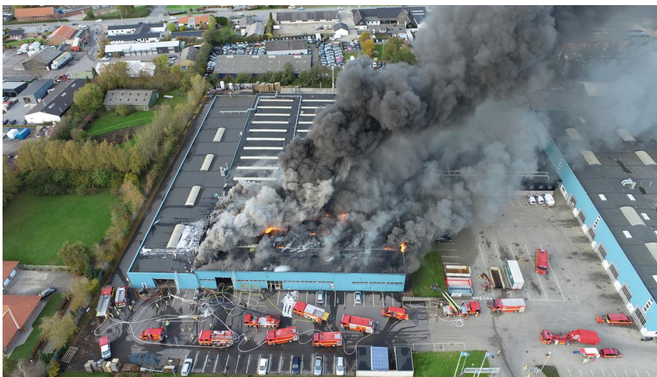
Figur 1 Brand hos Højbjerg Maskinfabrik i Galten, 2021
