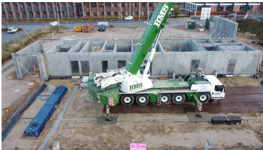
Station Aarhus Syd set fra værksteds-siden. BMS-kranen holder inde i det, der bliver til værksted om nogle få måneder.
