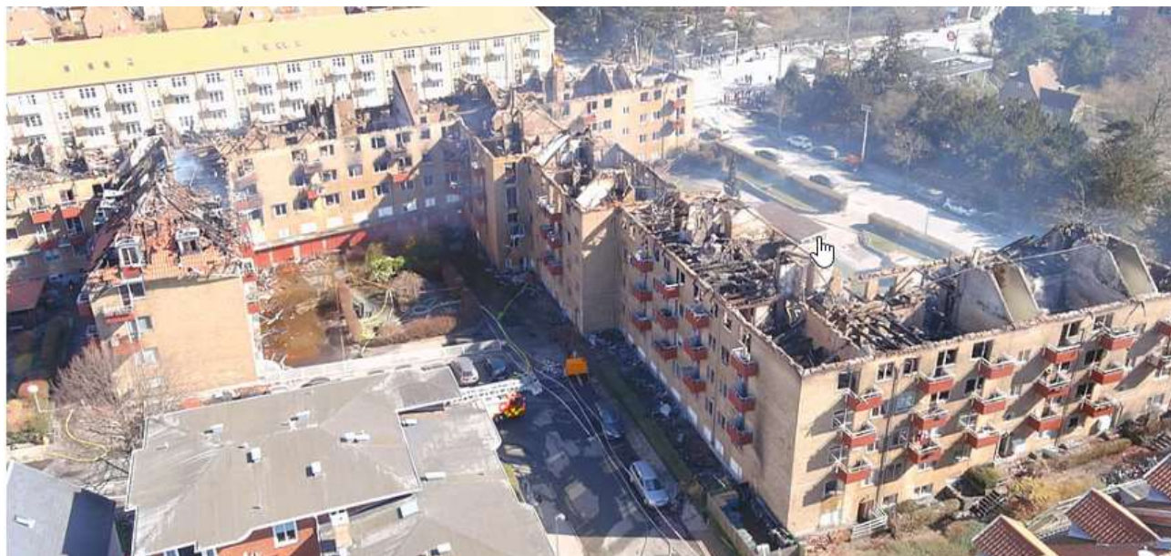
Figur 2 Etageejendom med 90 ødelagte lejligheder i Vanløse dagen derpå, 2022
